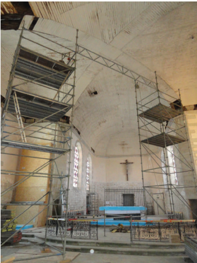
Montage de l'échafaudage de la croisée, en cours.
