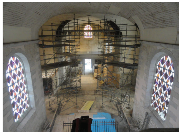
Échafaudage et installations complètes
