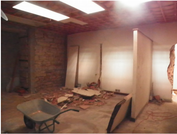
- Vue de l'intérieur de la chambre -
