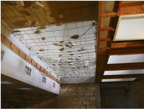
- autre étape : démolir la dalle du plafond -
